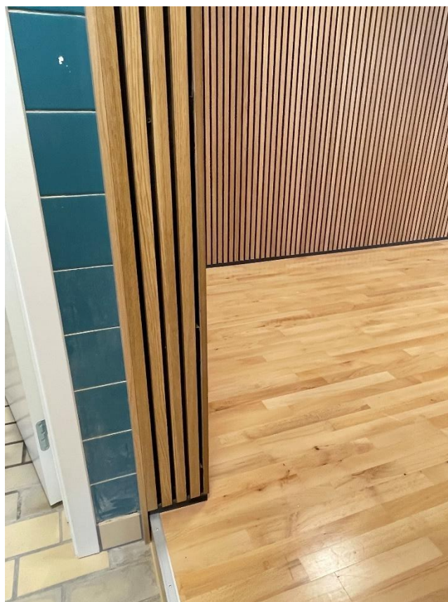
Billede 6: Det eksisterende - reparerede - gulv og den eksisterende væg sammen med det nye gulv og de nye akustikpaneler. Foto: Rytter Ark Group
