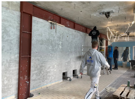
Renset betonvæg klar til nedrivning
