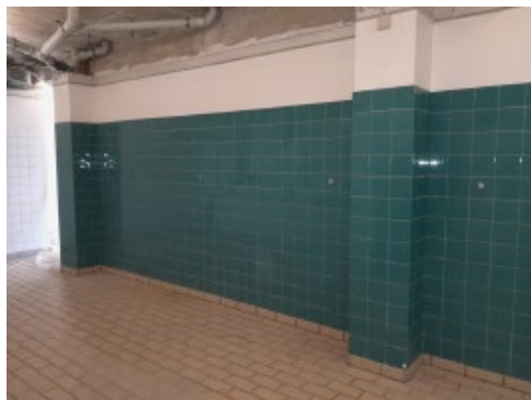
Før afmontering af klinker
