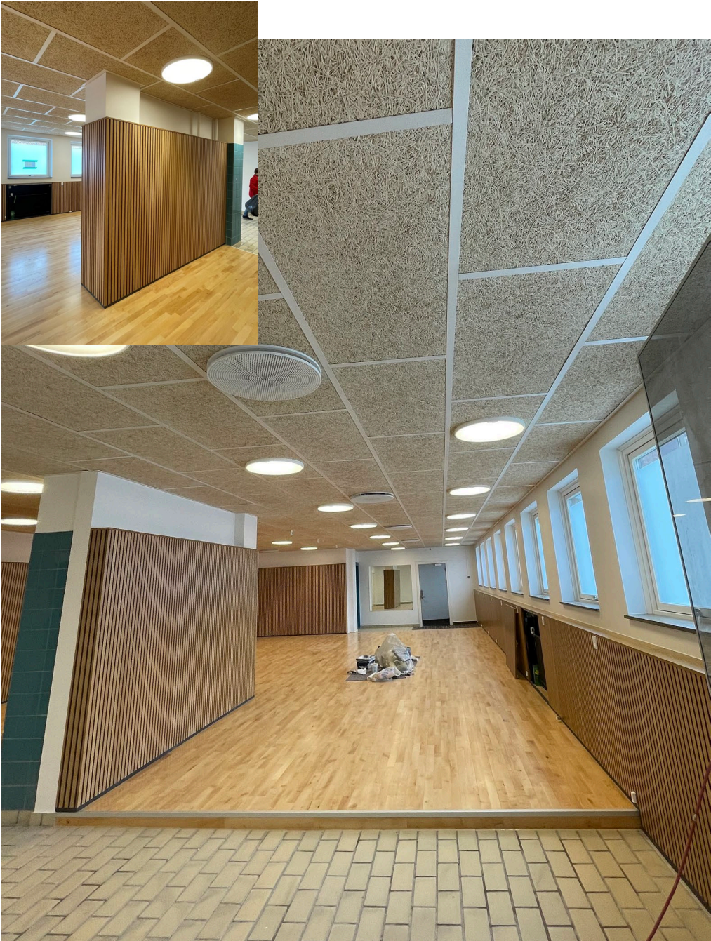
Omklædningsrum efter ombygning
