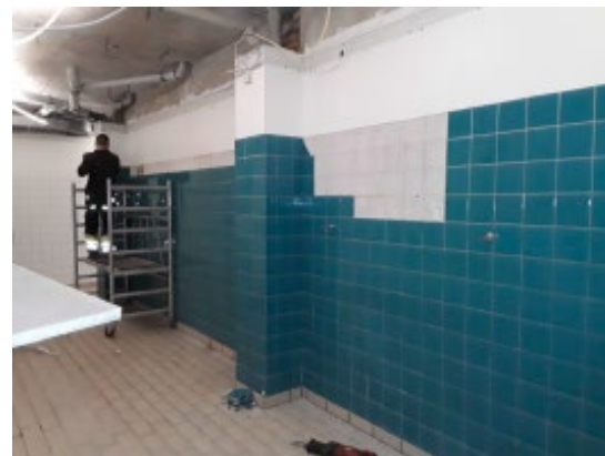
Påbegyndt nedtagning af fliser
