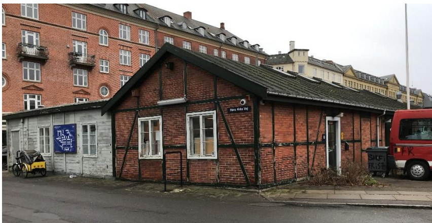
Billede 1: Maskinhuset som skal nedrives selektivt i forbindelse med opførelsen af Center for Diabetes. Set fra Hans Kirks Vej.
