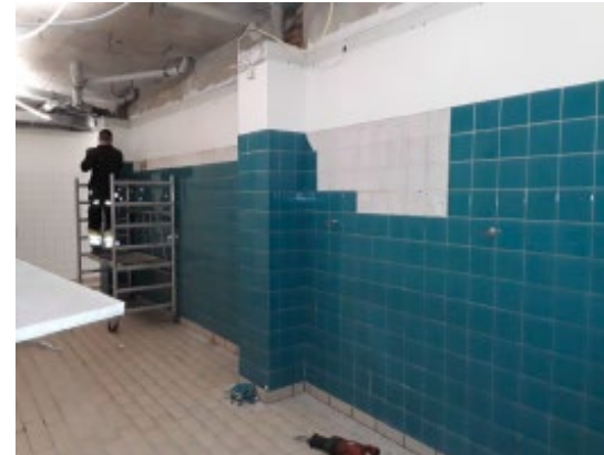
Påbegyndt nedtagning af fliser
