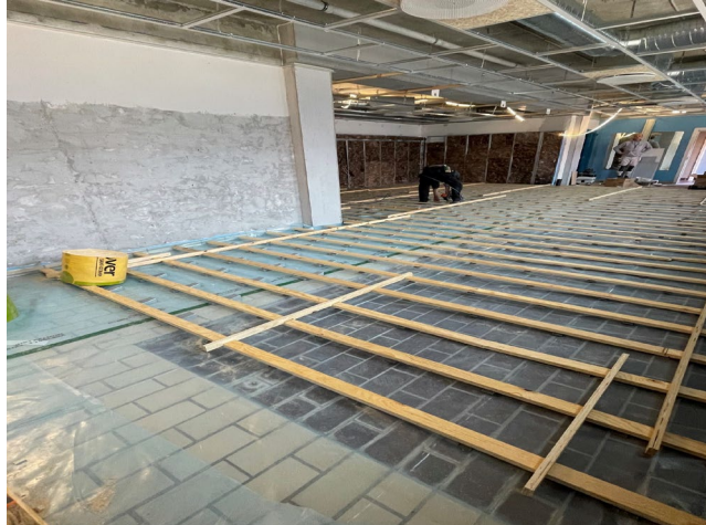
Lag-på-lag: Sportsgulv under opførelse
