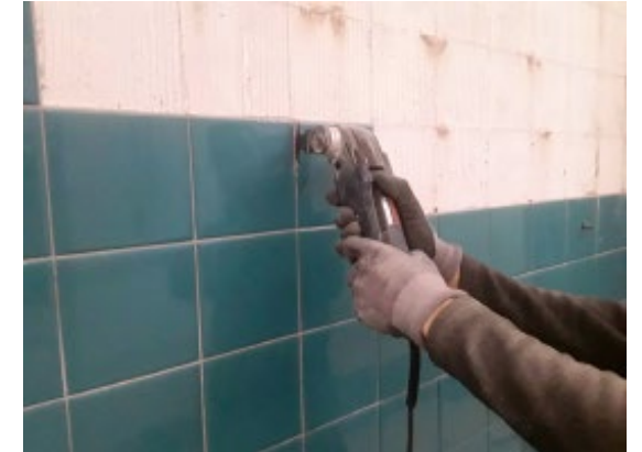
Anden metode ved brug af finecutter: Resultat: 25 hele fliser
