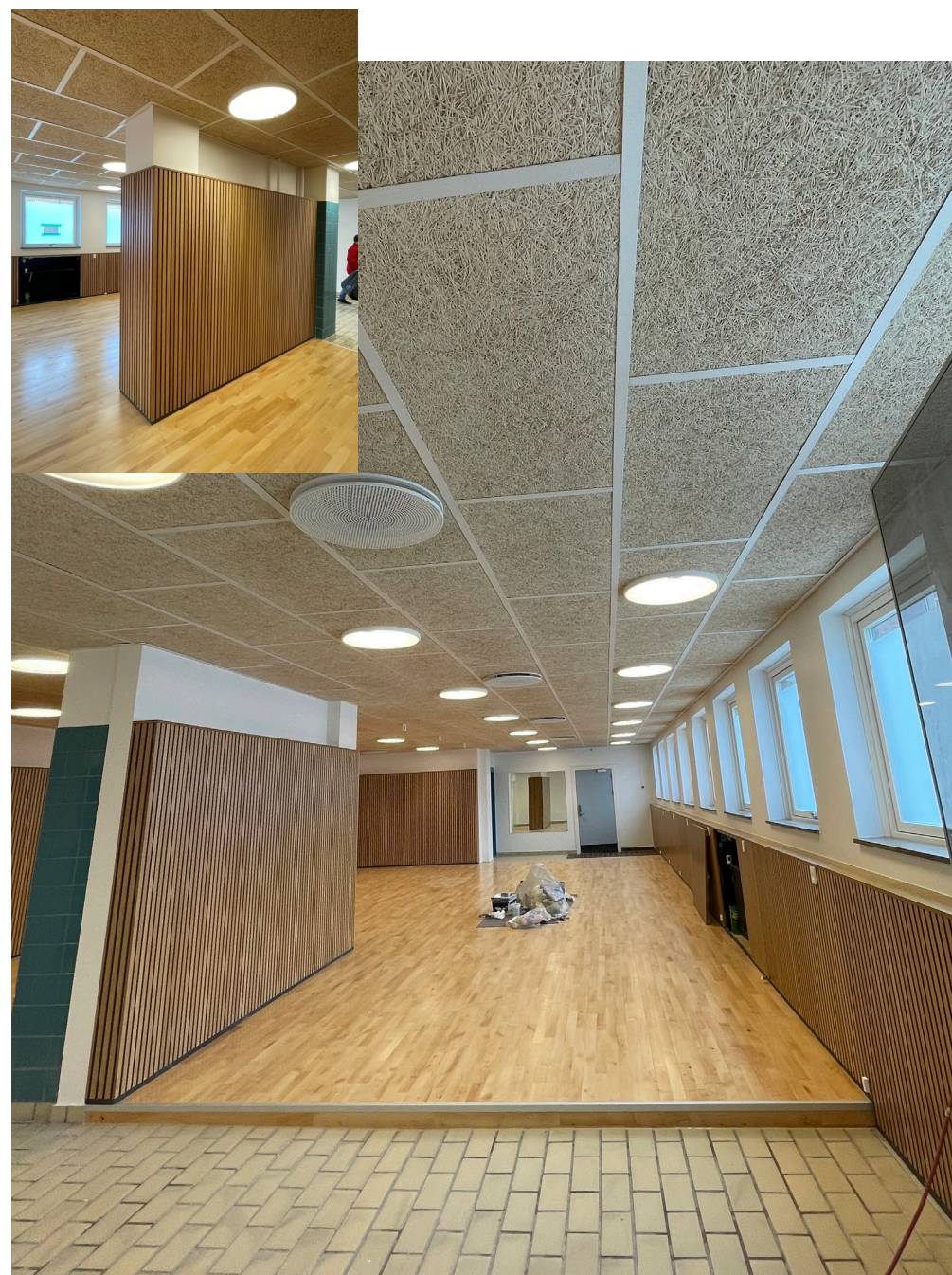
Omklædningsrum efter ombygning
