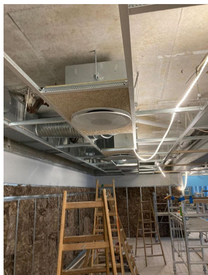
Få tilføjelser var nødvendige til de eksisterende ventilationskanaler: Her et nyt ind-/udblæsningsarmatur
