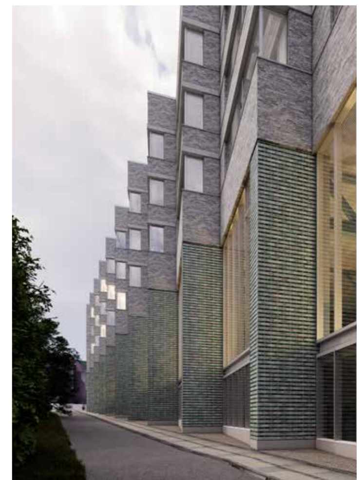
Byggeriet set fra cykelstien.
